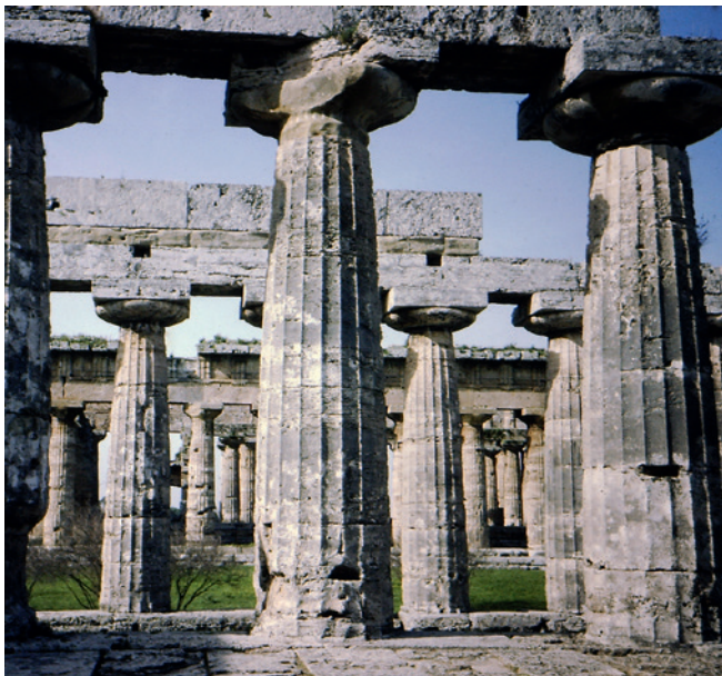
Abb. 11/12: Analogie der Säulenform zu einer schwingenden Seite bei der Tempelanlage von Paestum
