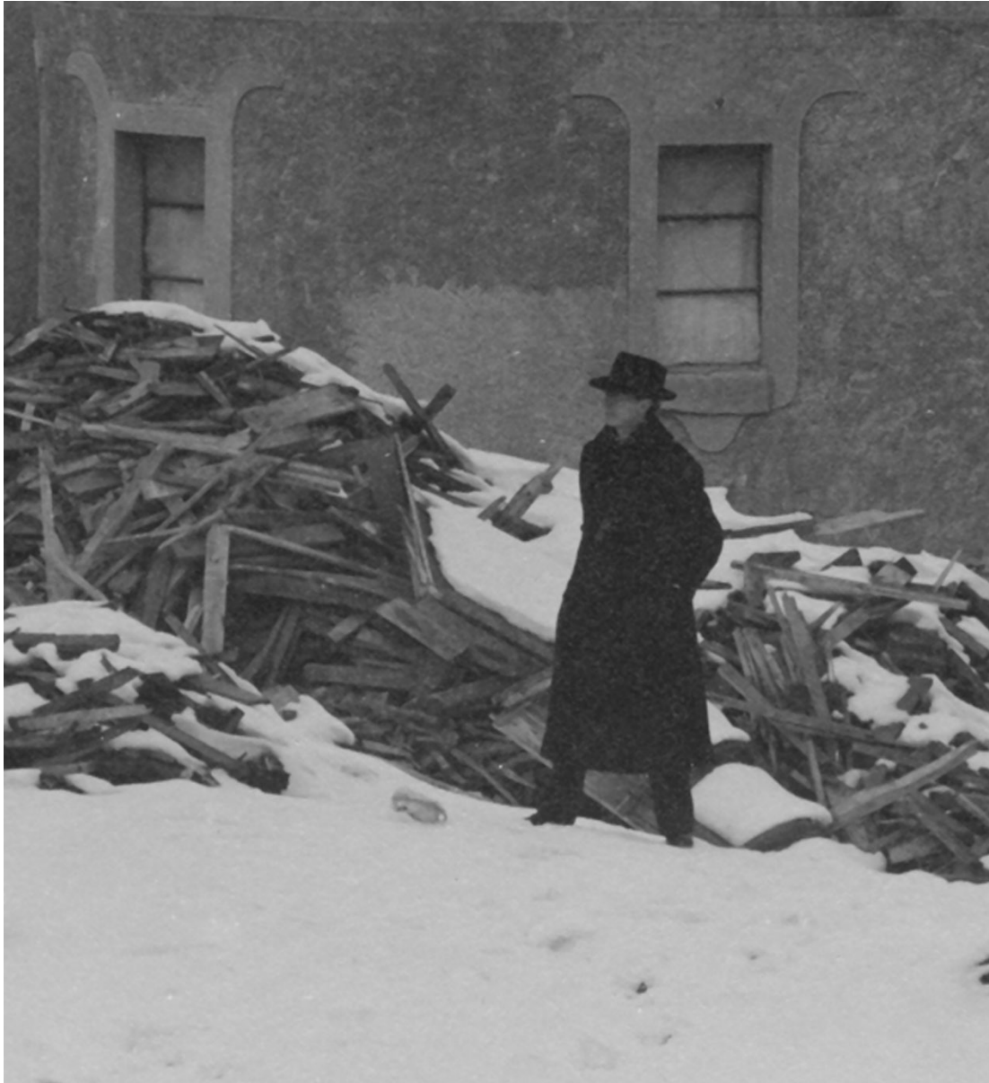
Rudolf Steiner vor dem im Bau befindlichen Heizhaus, 6. Februar 1915 (Foto: O. Rietmann)
